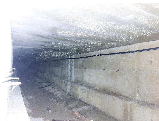
Galleria lato campo sportivo seminterrato
