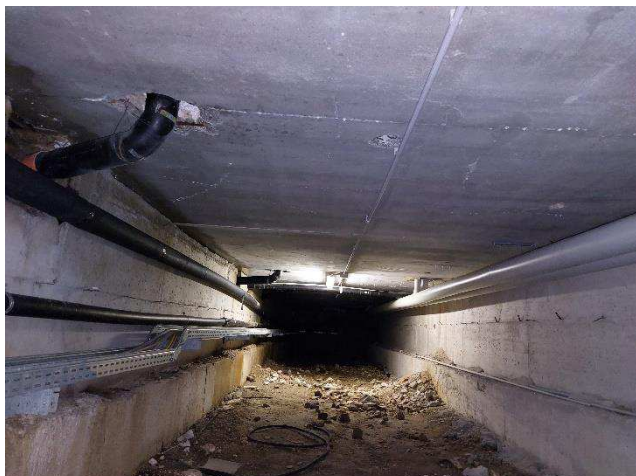
Galleria lato ferrovia seminterrato
