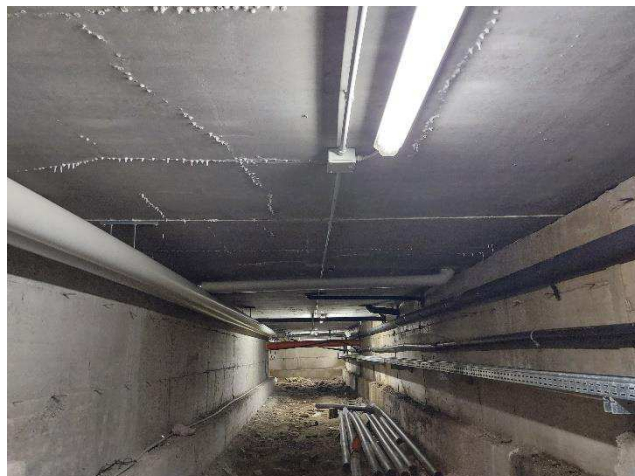
Galleria lato ferrovia seminterrato
