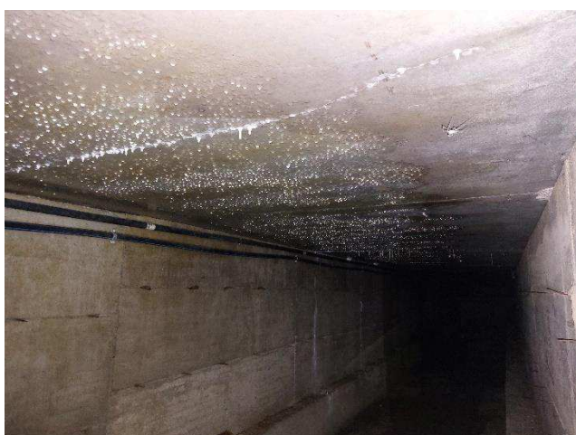
Galleria lato campo sportivo seminterrato
