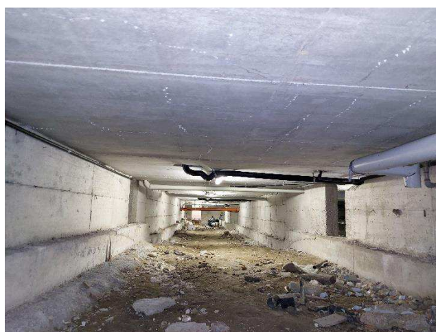
Galleria centrale seminterrato
